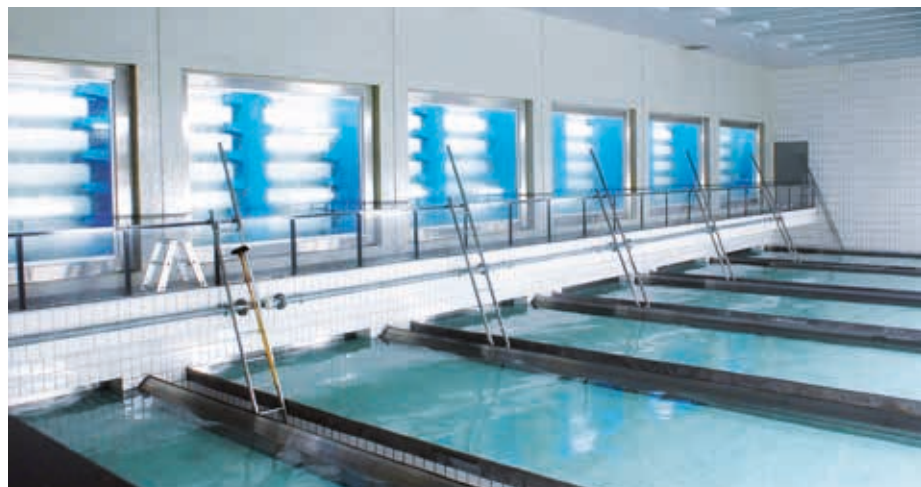
Filterhalle im Wasserwerk Hintermark bei Heusenstamm.
