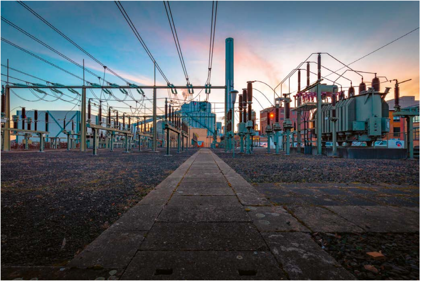
EVO-Umspannwerk am Nordring in Offenbach. Drei neue Umspannwerke entstehen in Offenbach.
